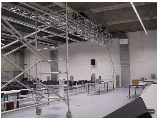
Spleissarbeiten auf dem Gerüst
