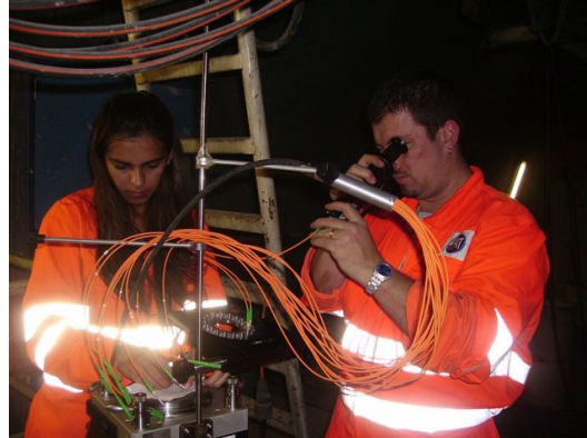
Nach dem Schleif- und Polierprozess werden Die Steckerflächen einzeln kontrolliert
