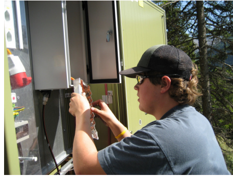
Installation von vorkonfektionierten Kabeln
