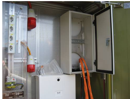
Installation von vorkonfektionierten Kabeln
