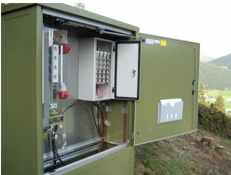
Zwischenstation für Beschneigungsanlage
